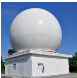
LA STATION DE RÉCEPTION VIGISAT À BREST
